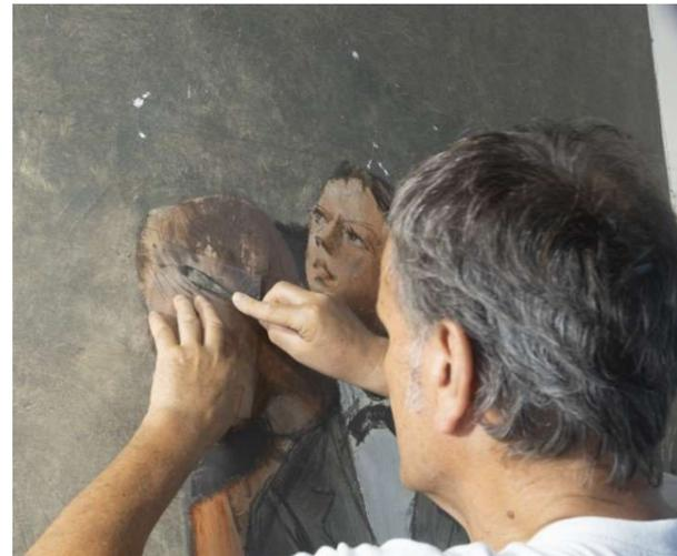
In alcune zone si è reso necessario procedere a consolidare l'intonaco di fondo mediante infiltrazioni di malta premiscelata esente da sali efflorescibili, applicata con iniezioni manuali, mentre nella zona inferiore della parete si è proceduto alla rimozione meccanica con scalpelli dell'intonaco cementizio, molto dannoso per la conservazione, e all'applicazione al suo posto di un intonaco di sabbia e grassello di calce simile a quello originale.
